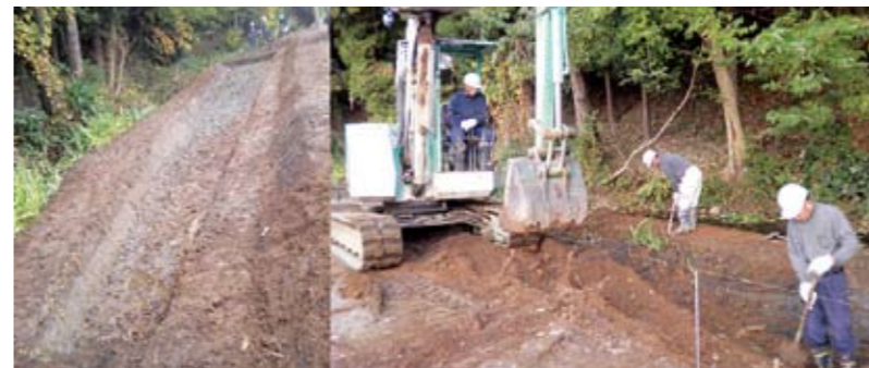
重機での整備作業
