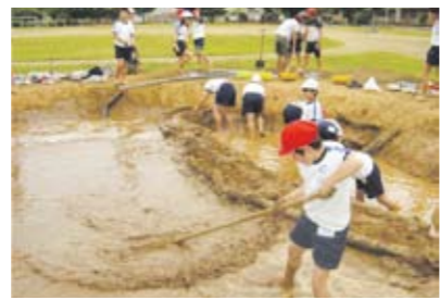
ビオトープの改修(粘土貼り)
