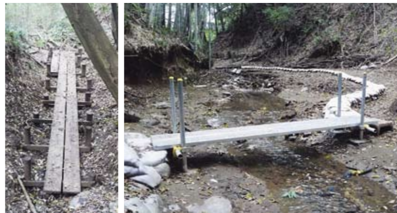
【整備した木道と橋】
