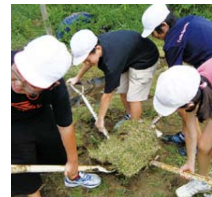
芝生を切り取り川岸に貼る作業
